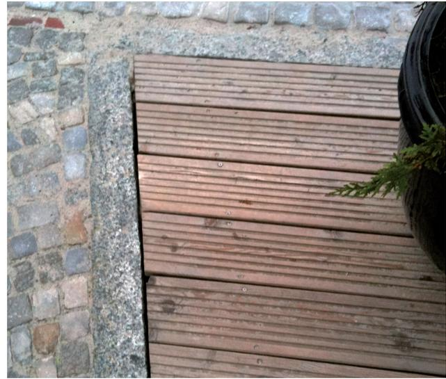
Erdverbau ohne ausreichende Umlüftung – Wegen fehlender Hinterlüftung sind hierfür nur sehr und gering bis mäßig schwindende Harthölzer geeignet. Auf eine Mindestdurchlüftungsfuge ist besonders zu achten.
