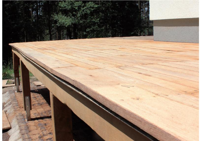
Senkrechte Bauteile wie Stützen, an denen das Wasser schnell ablaufen kann, sind der Gebrauchsklasse 3.1, der waagrecht exponierte Belag ist der Gebrauchsklasse 3.2 zuzuordnen.
