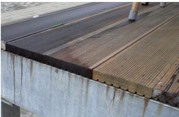
Auswaschungen aus Bangkirai, die sich nur durch eine konstruktive Lösung z. B. Abtropfblech verhindern lassen.
