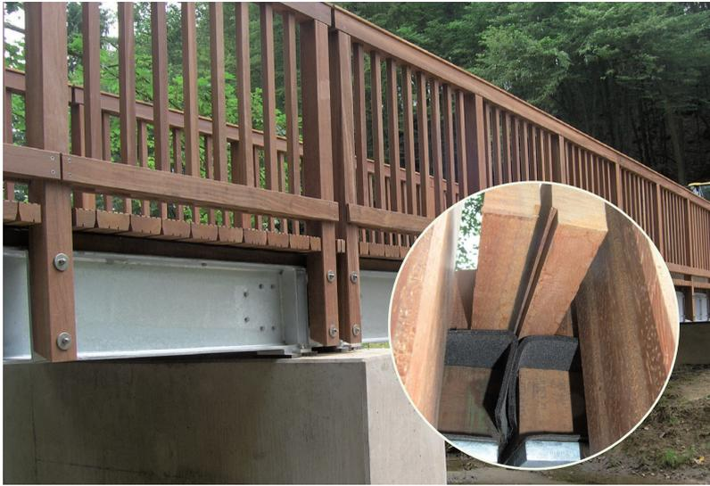
Trennlagen/Abdeckungen zwischen Belag und Auflagenhölzern sowie Auflagenholz und Stahlträger
