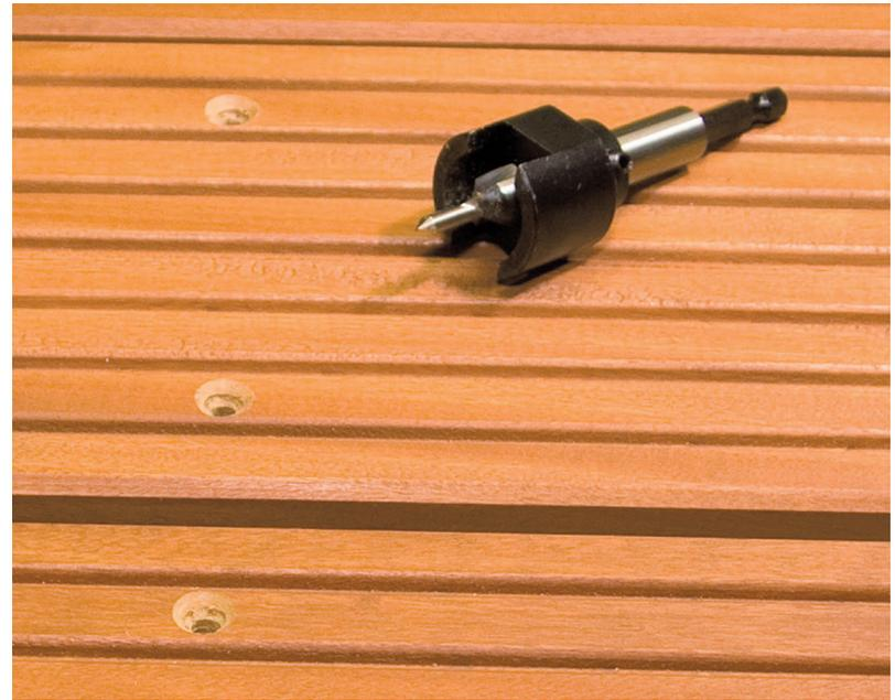
Verschraubung auf den Stegen der Nutenseite – Für eine saubere Verarbeitung empfiehlt sich das Vorbohren mit dem Versenker. Dabei ist der Geometrie des Schraubenkopfes Rechnung zu tragen.
