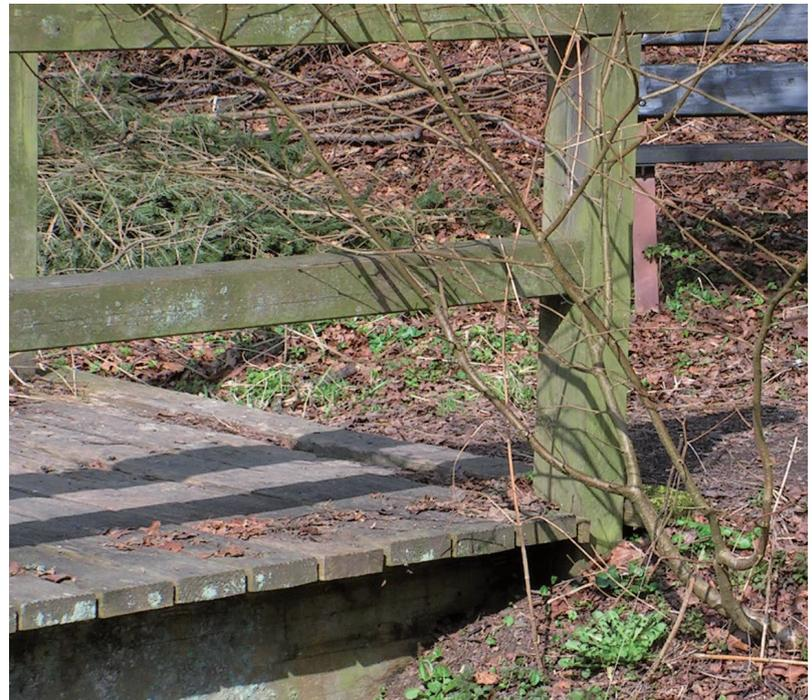
Der Belag ist durch Laub, Schmutz und Erdreich der Gebrauchsklasse 4 nach DIN 68800 Teil 1 ausgesetzt.
